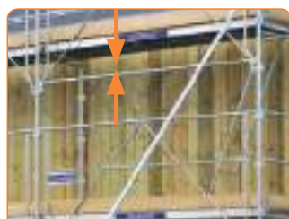
Travée d'accès avec lisse de protection au-dessus du garde-corps.
