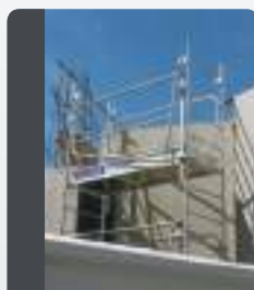
p.85 Travaux/circulation banches AC BANCHE p.86 ENTRE-BANCHE
