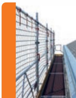
ÉCHAFAUDAGE DE COUVREUR p.150 ▶ 151
