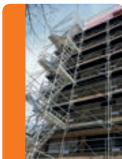
TOUR D'ACCÈS p.152 ▶ 153
