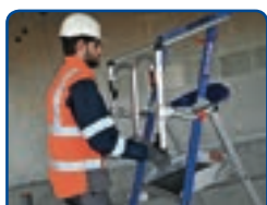
Mise en place du garde-corps en un seul geste
